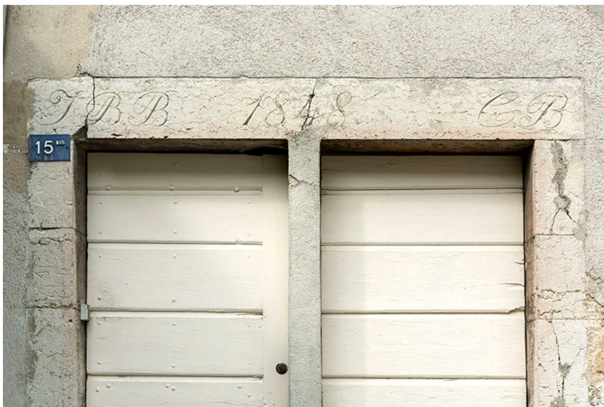
Maison côté cour : linteau daté 1848.
