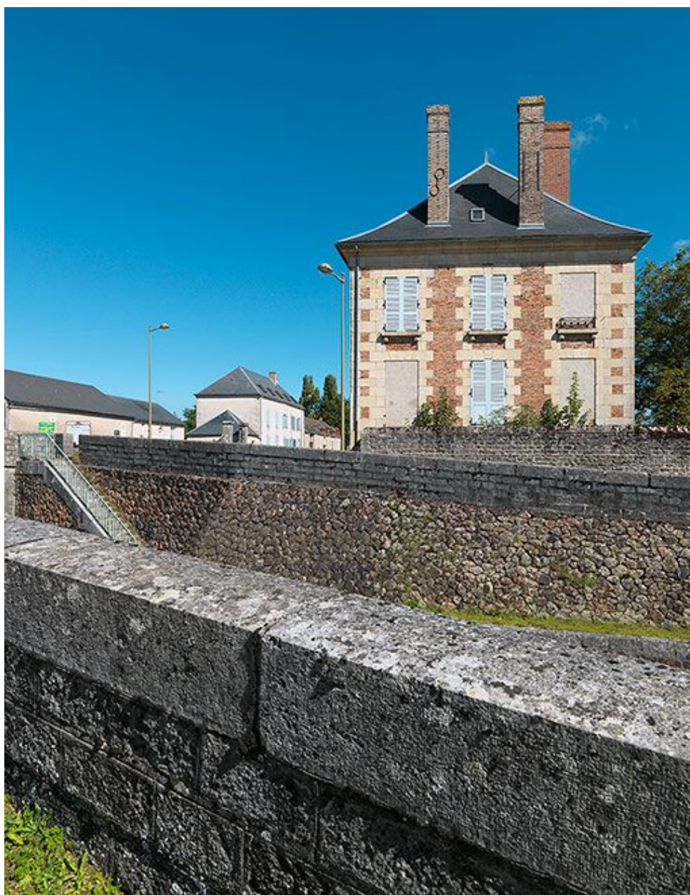
Façade latérale sud.
