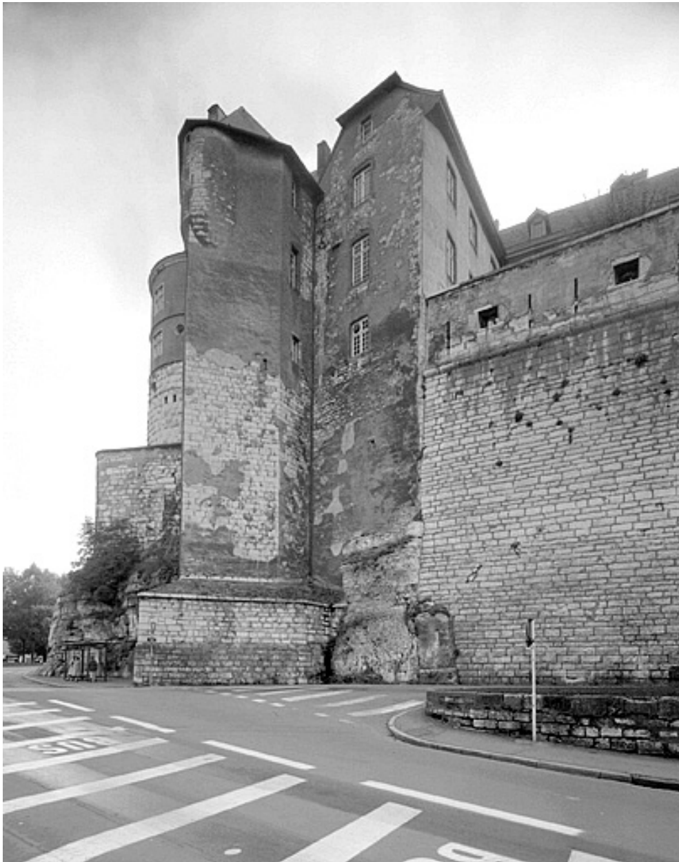
Tour en éperon et aile en retour du corps de logis principal.
