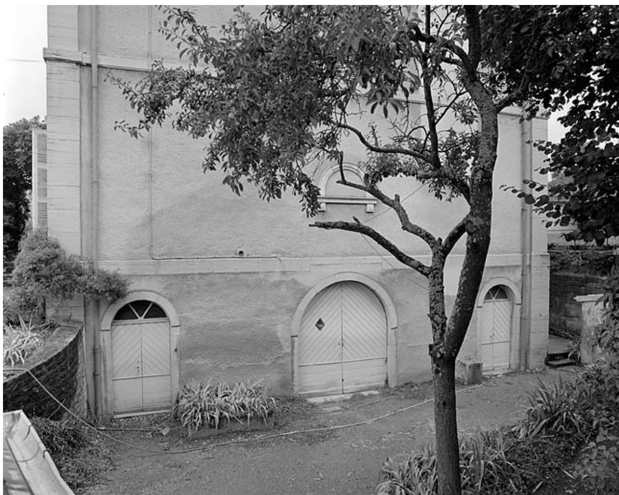
Façade latérale droite.
