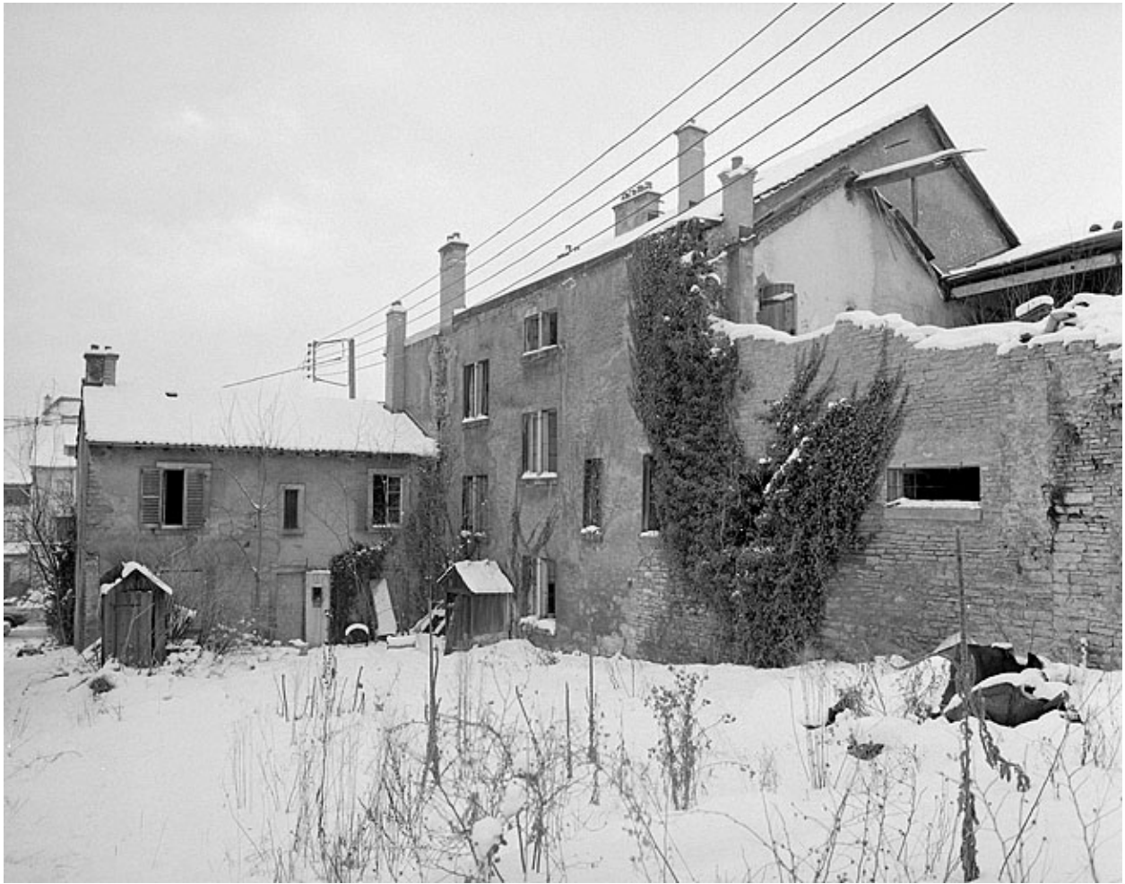
Corps de bâtiment sur rue, façade est.
