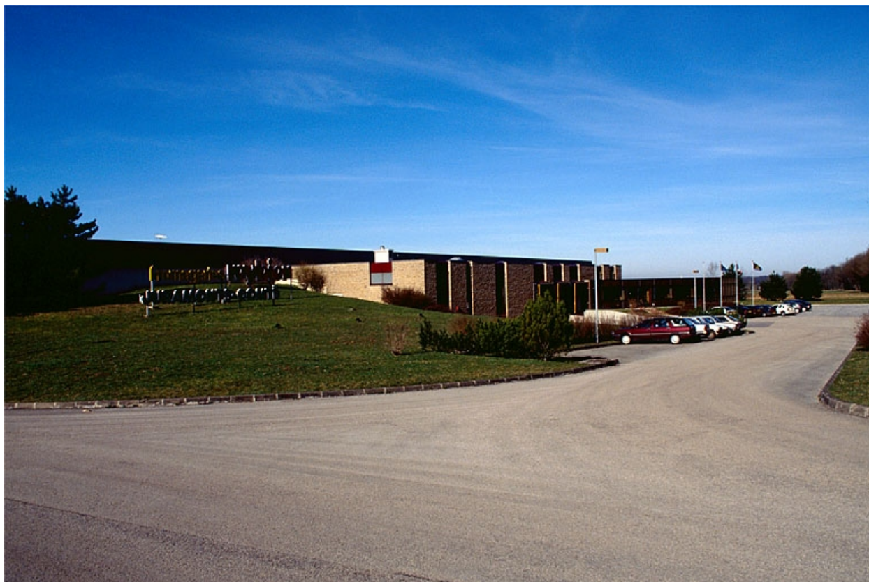
Chaufferie, quai d'expédition et bureaux depuis l'entrée.
