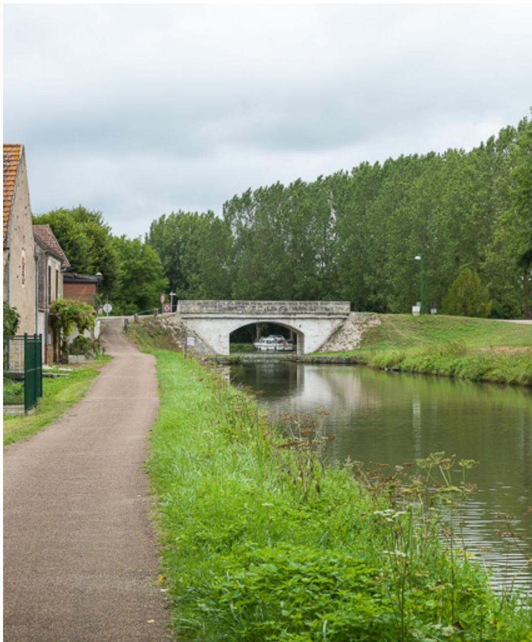
Vue d'ensemble du site et du pont.
