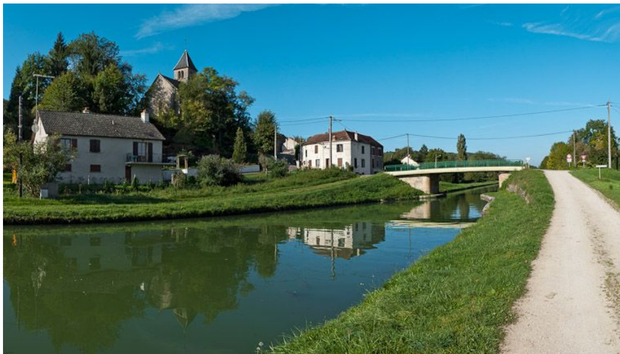
Vue générale du pont et de son environnement.
