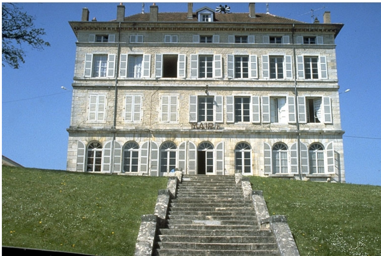
Façade antérieure du logement patronal.
