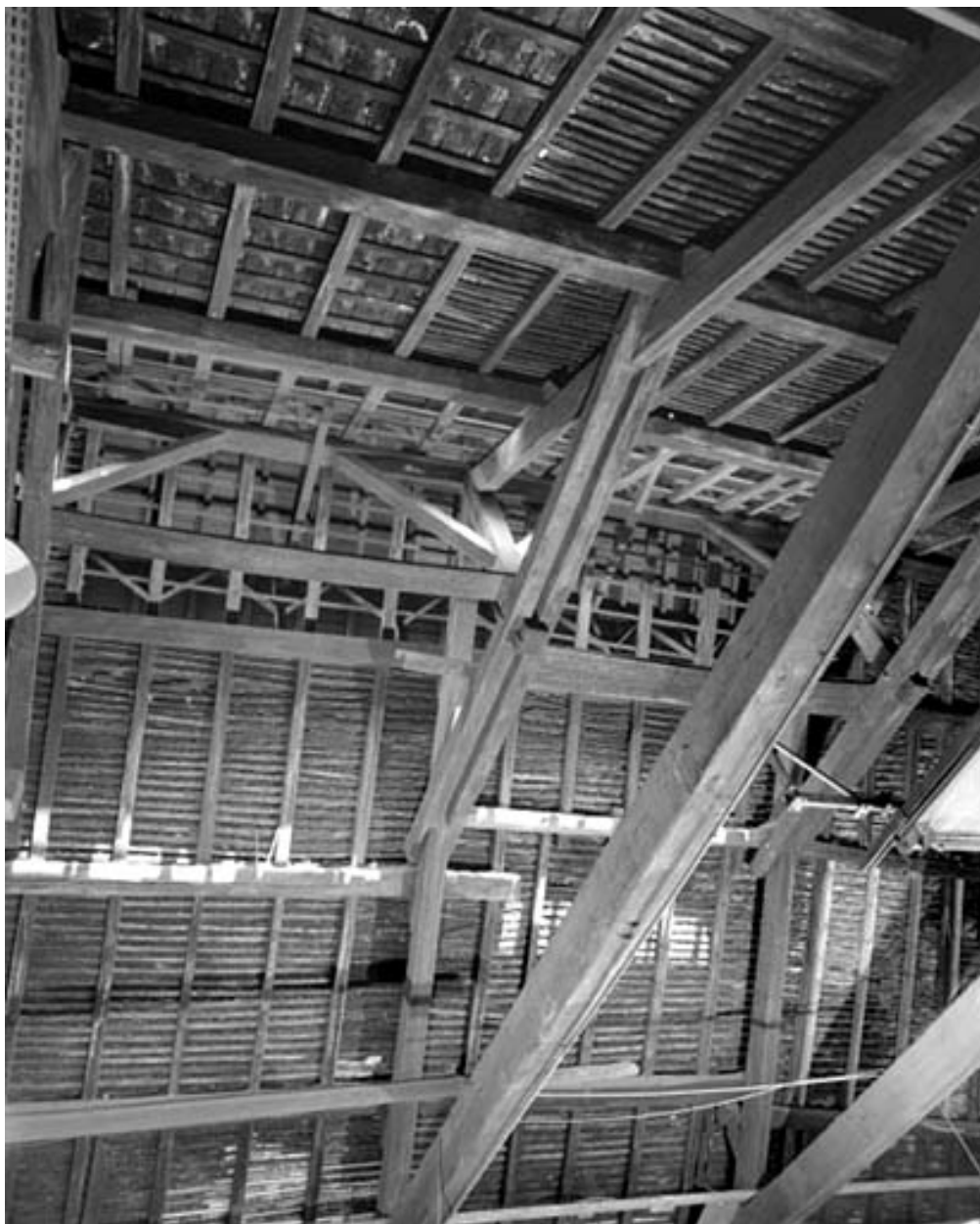
Charpente du lanterneau.
