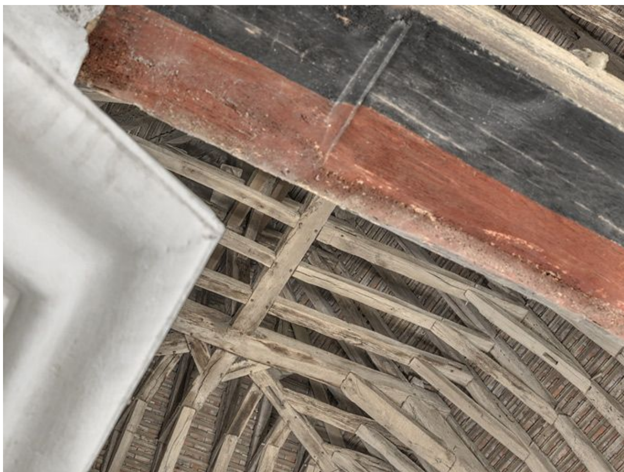
Combles : charpente de la tour carrée, détails.
