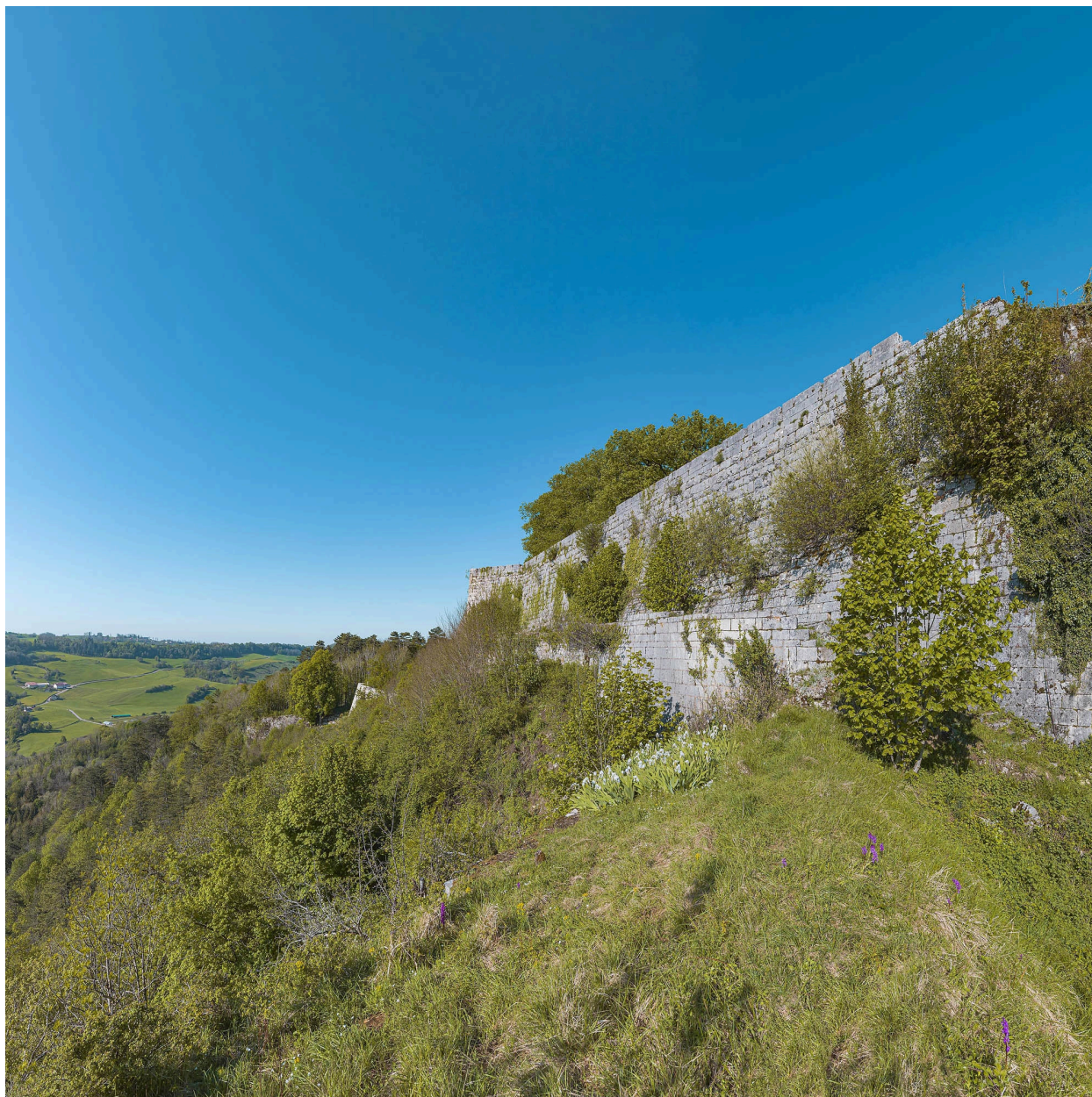
Rempart du front est.
