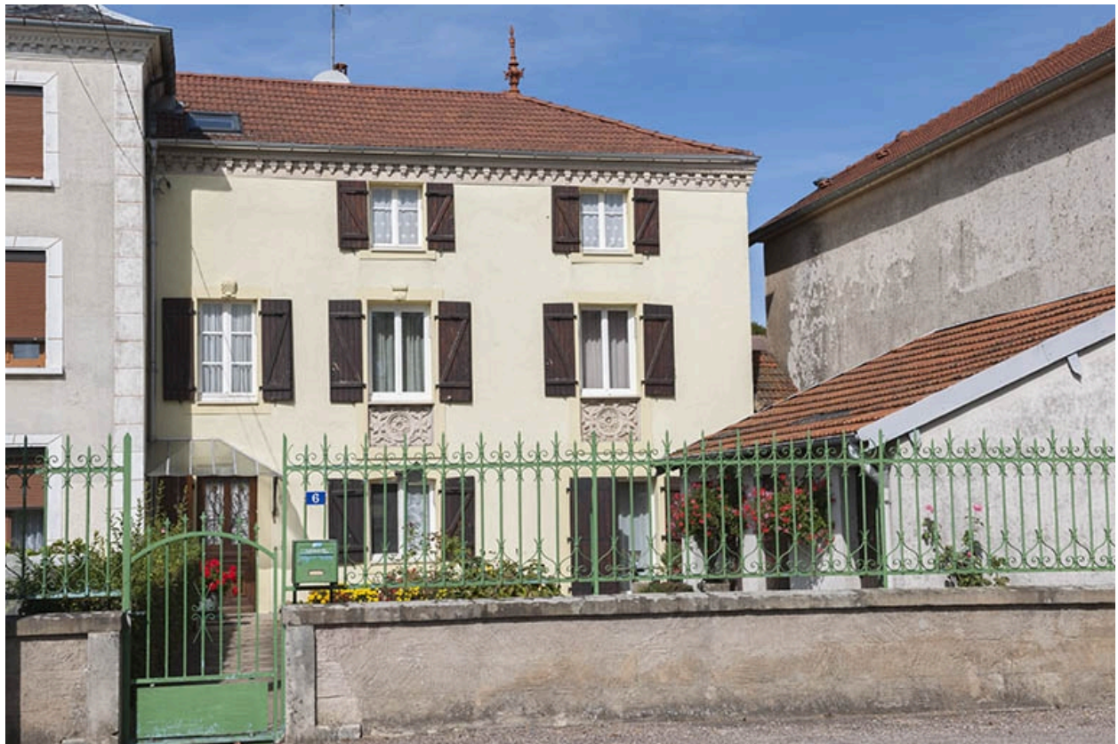
Façade antérieure, partie est.
