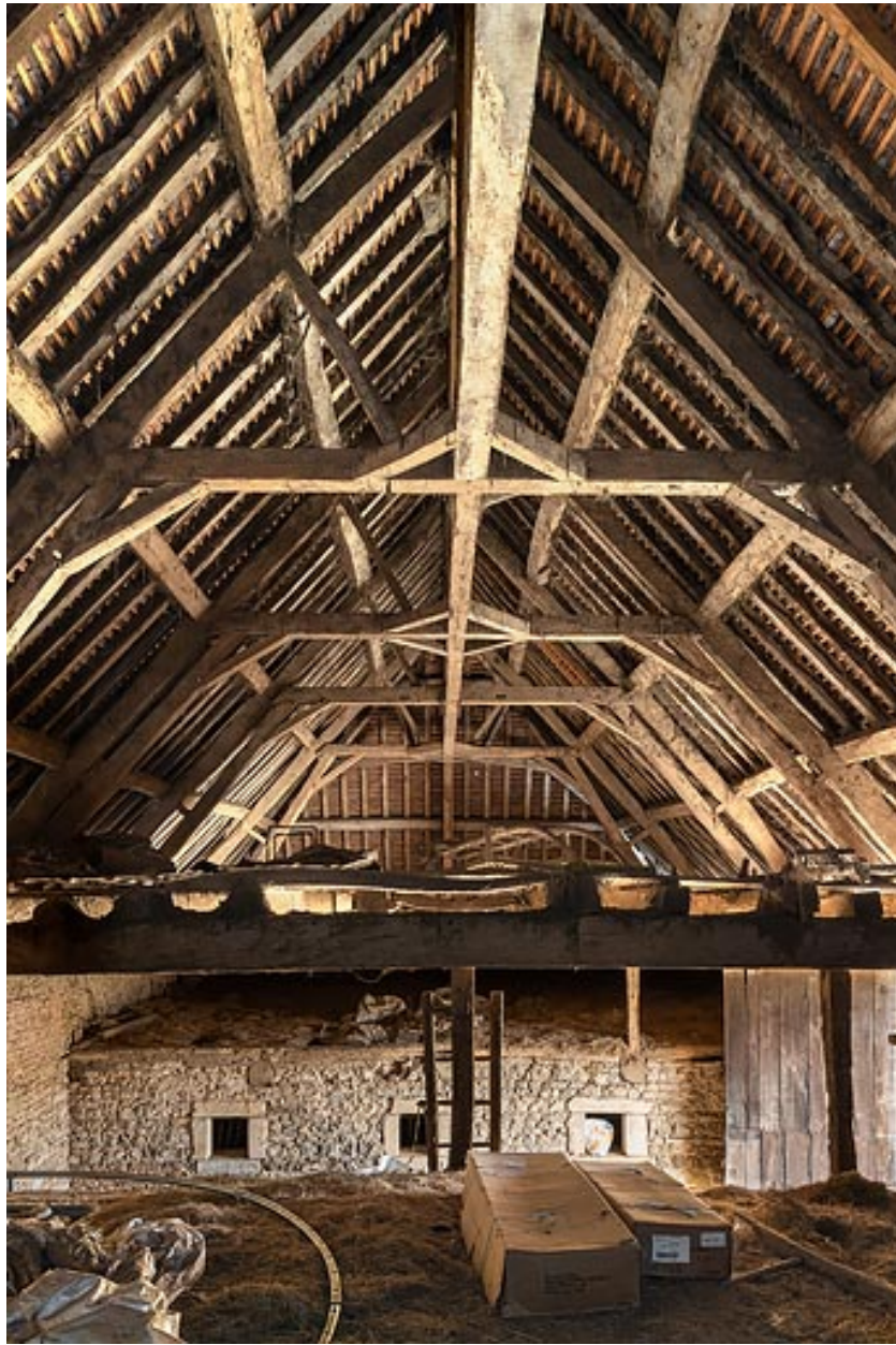
Charpente et fenil de la grange
