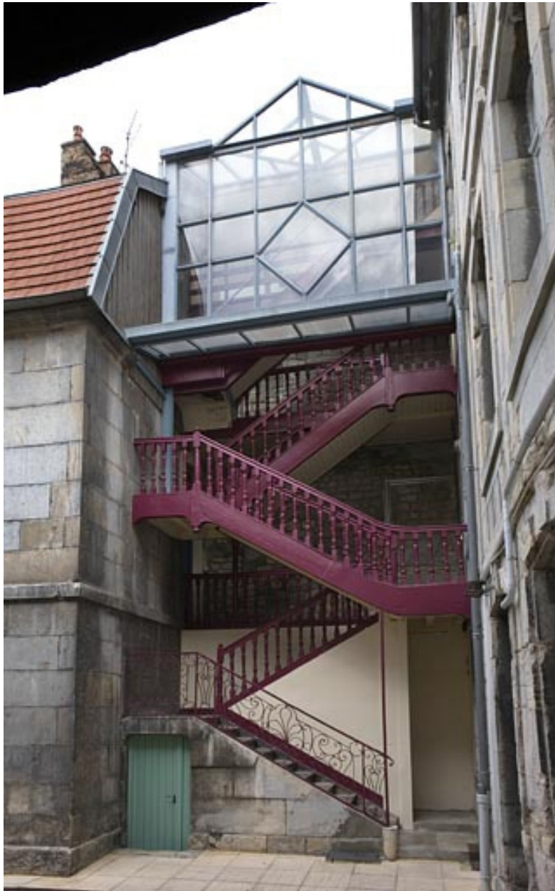
Vue d'ensemble de l'escalier à cage ouverte.
