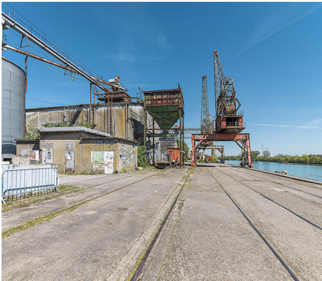
Trémie, grues et rails le long du quai.
