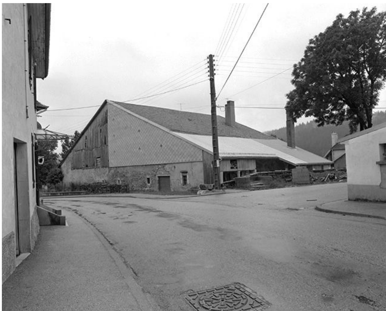
Pignon sur rue et goutterot.
