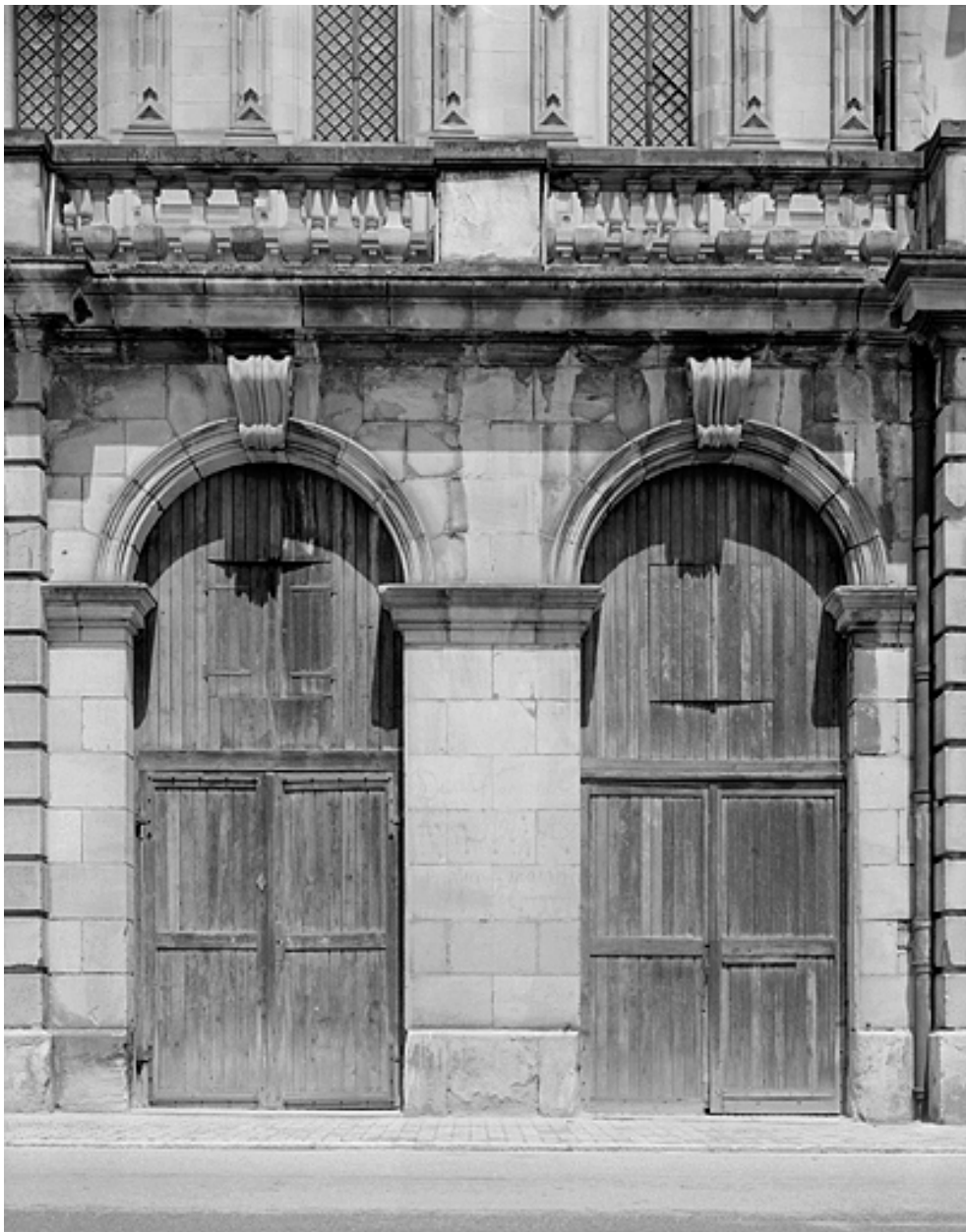
Baies des boutiques.
