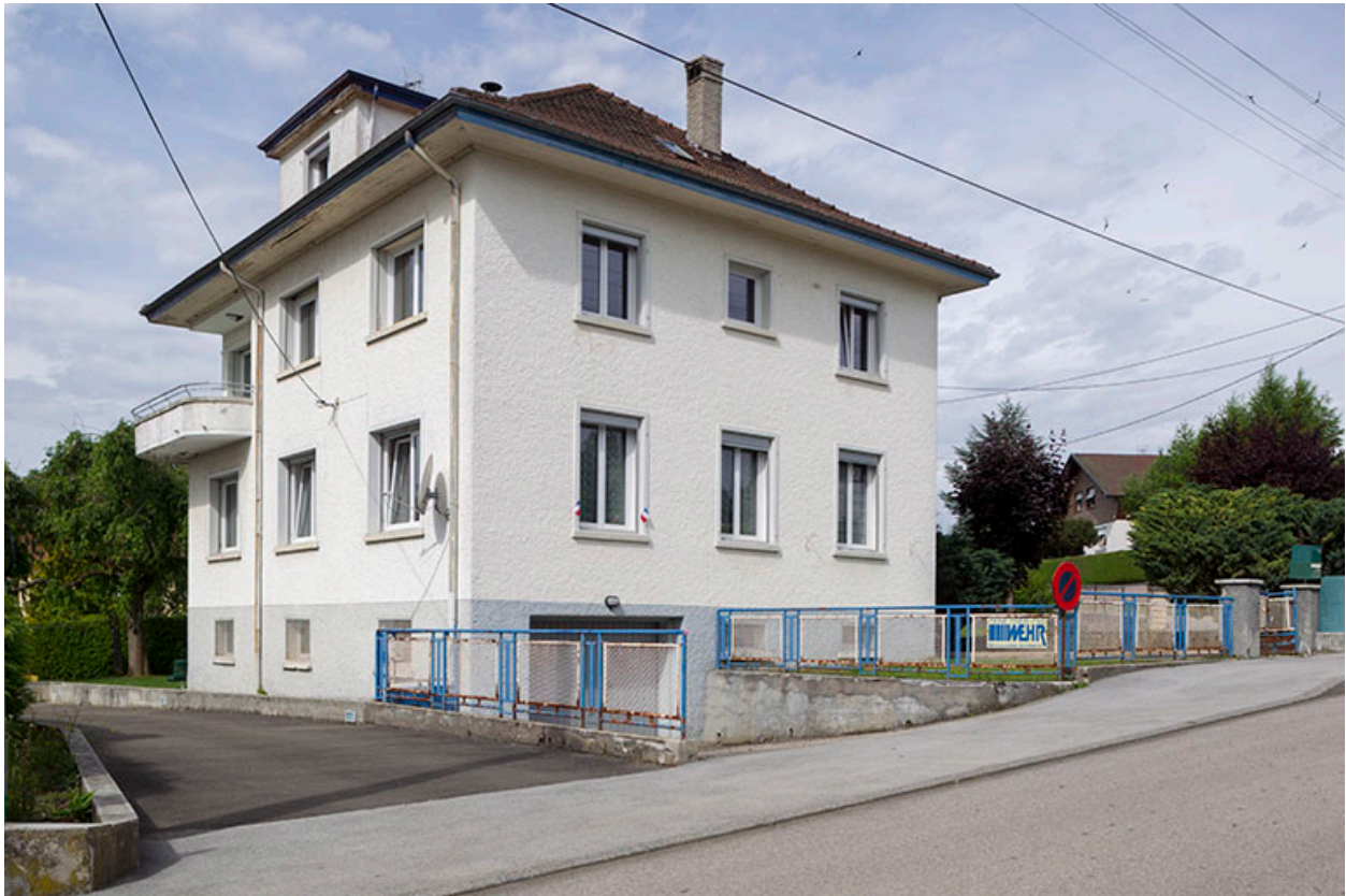
Logement patronal, vu de l'est (façades antérieure et latérale gauche).
