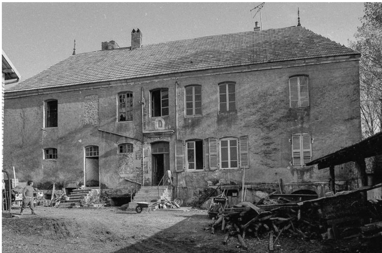
Façade antérieure sur cour.
