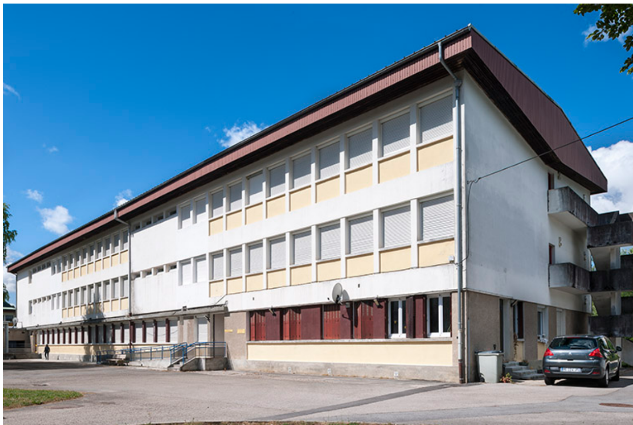
Internat : façade antérieure.
