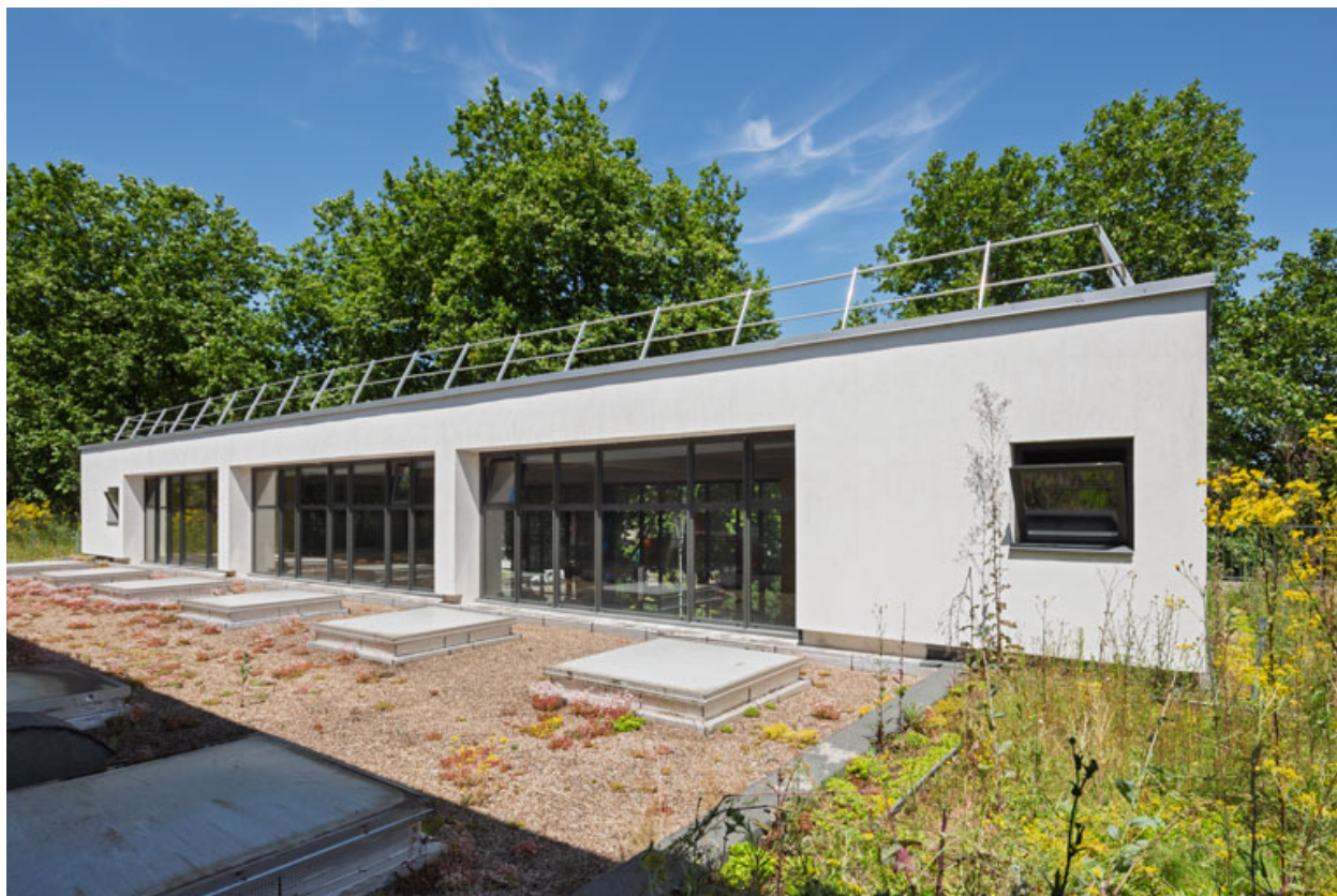
Maison des sports : partie supérieure du petit gymnase, depuis le toit.
