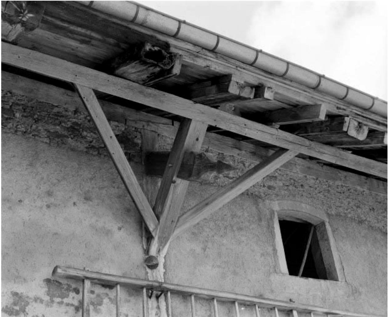
Détail: extrémité d'arbalétrier et assemblage de charpente.
