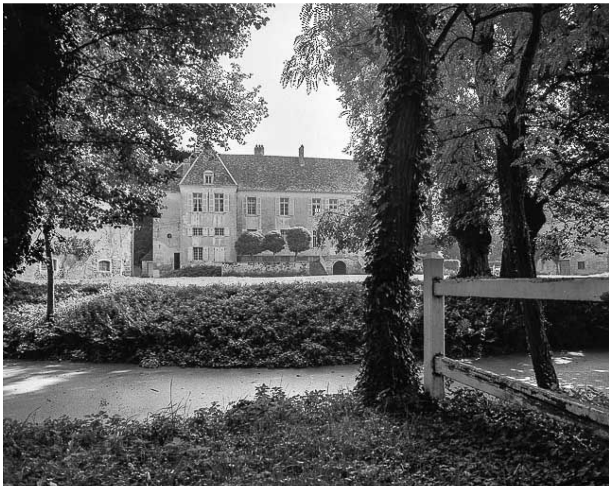
Façade antérieure et fossé.
