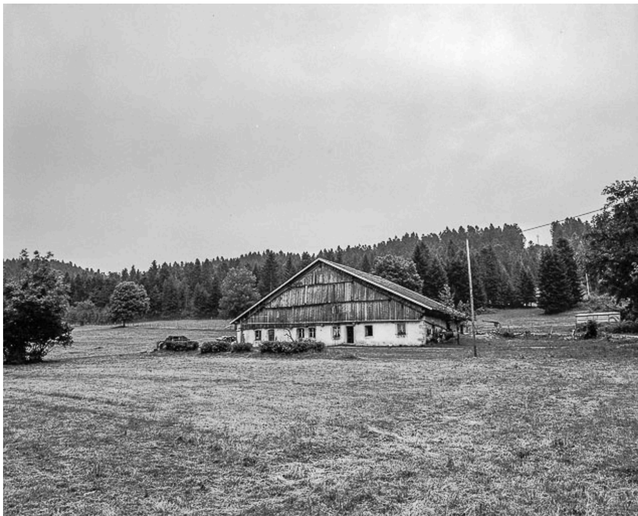
Ferme située au lieu-dit Combe d'Abondance, cadastrée B1 139 : vue d'ensemble.
