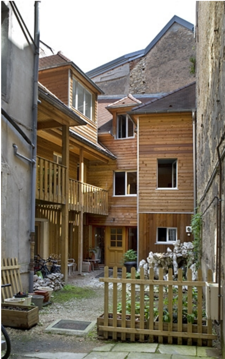
Logis secondaire : vue d'ensemble.
