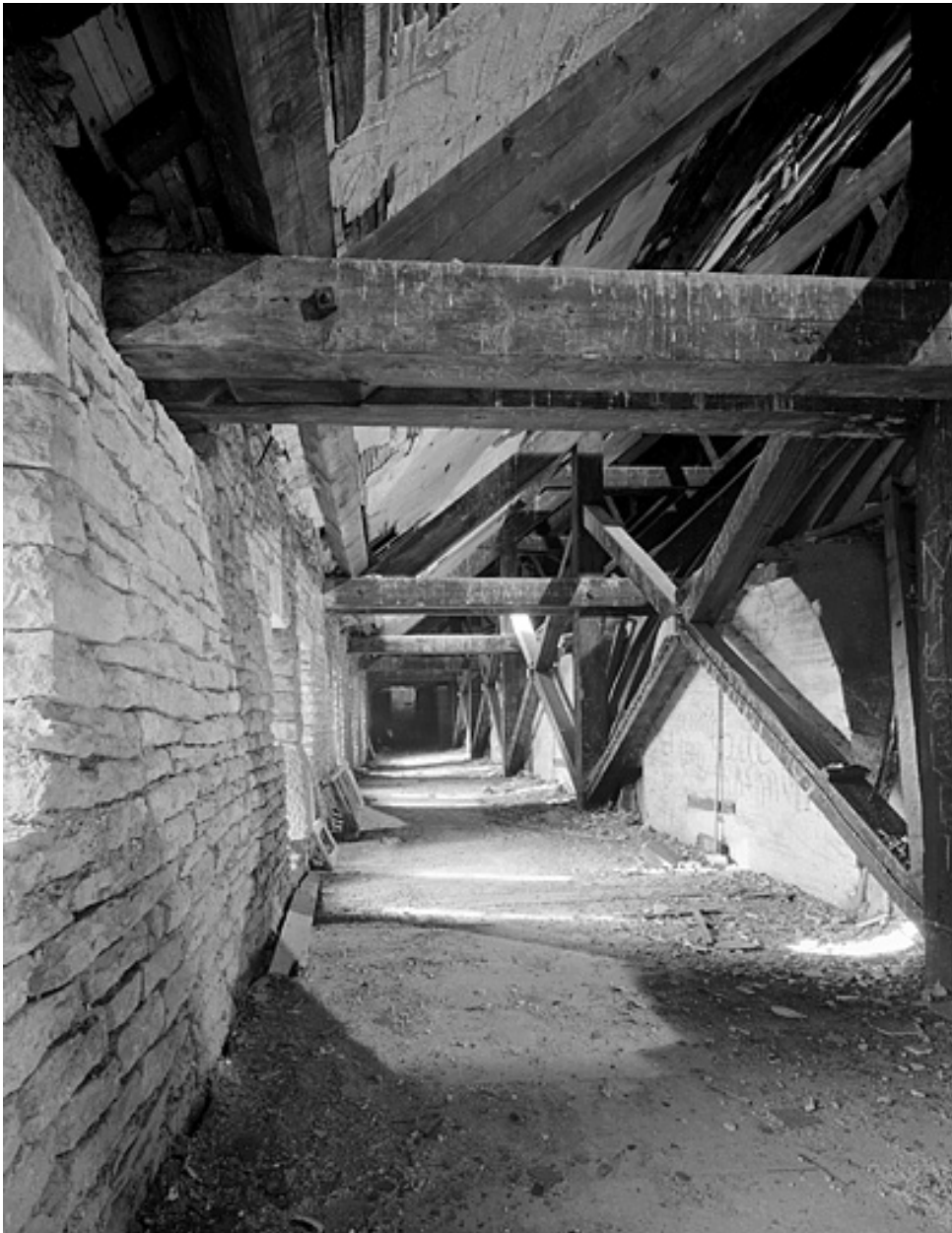
Charpente au-dessus de la tribune droite.
