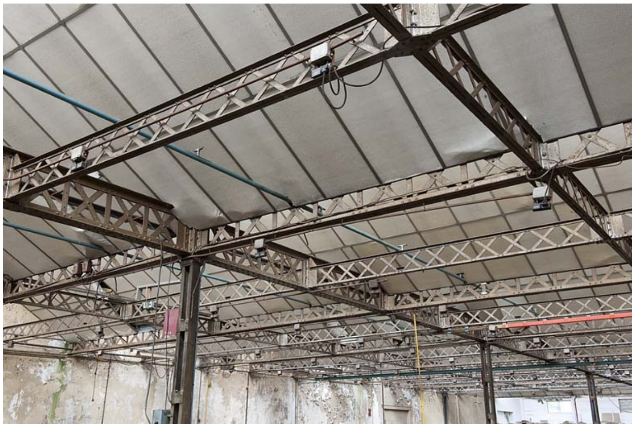
Atelier de fabrication. Éléments de charpente métallique.
