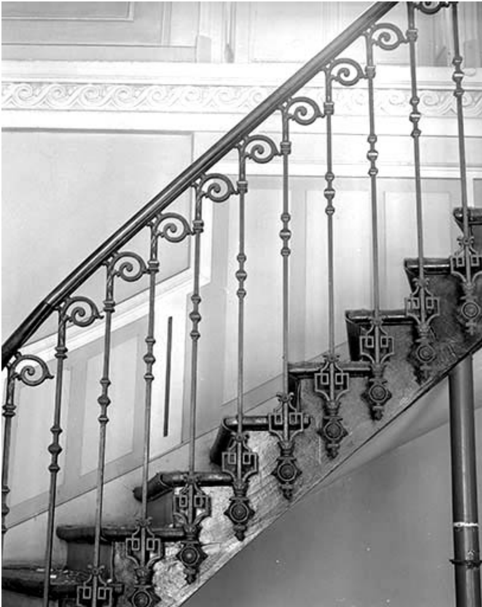
Escalier des bureaux : détail de la rampe.
