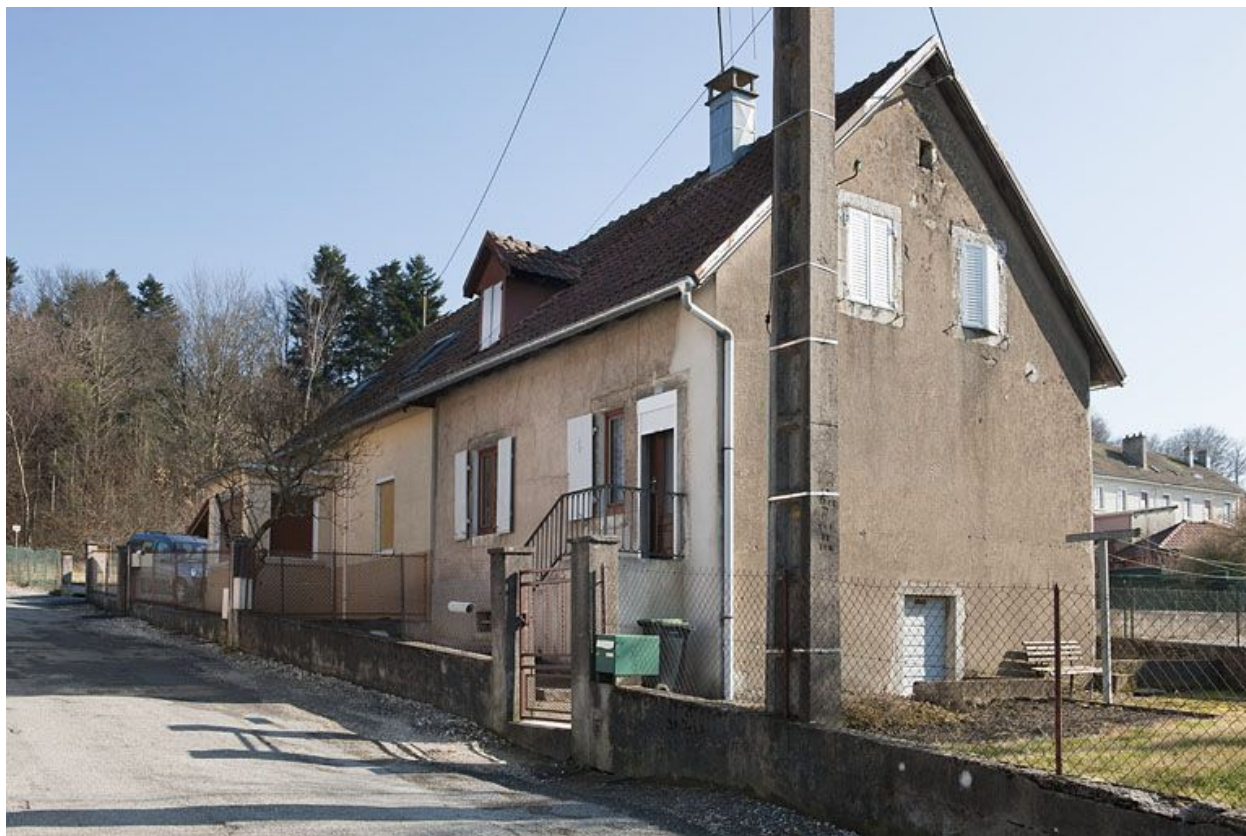
Maison jumelée rue d'Alsace.
