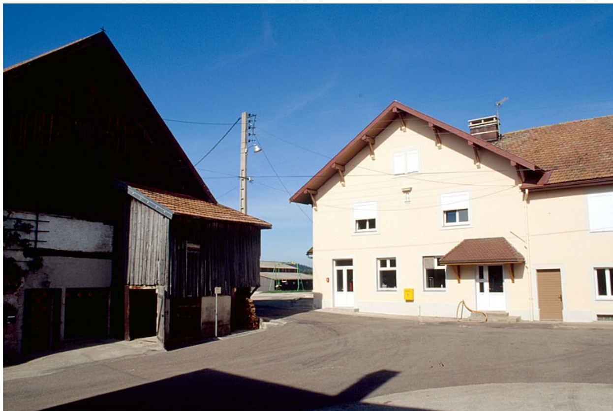
Pignon sud-est de la fromagerie.
