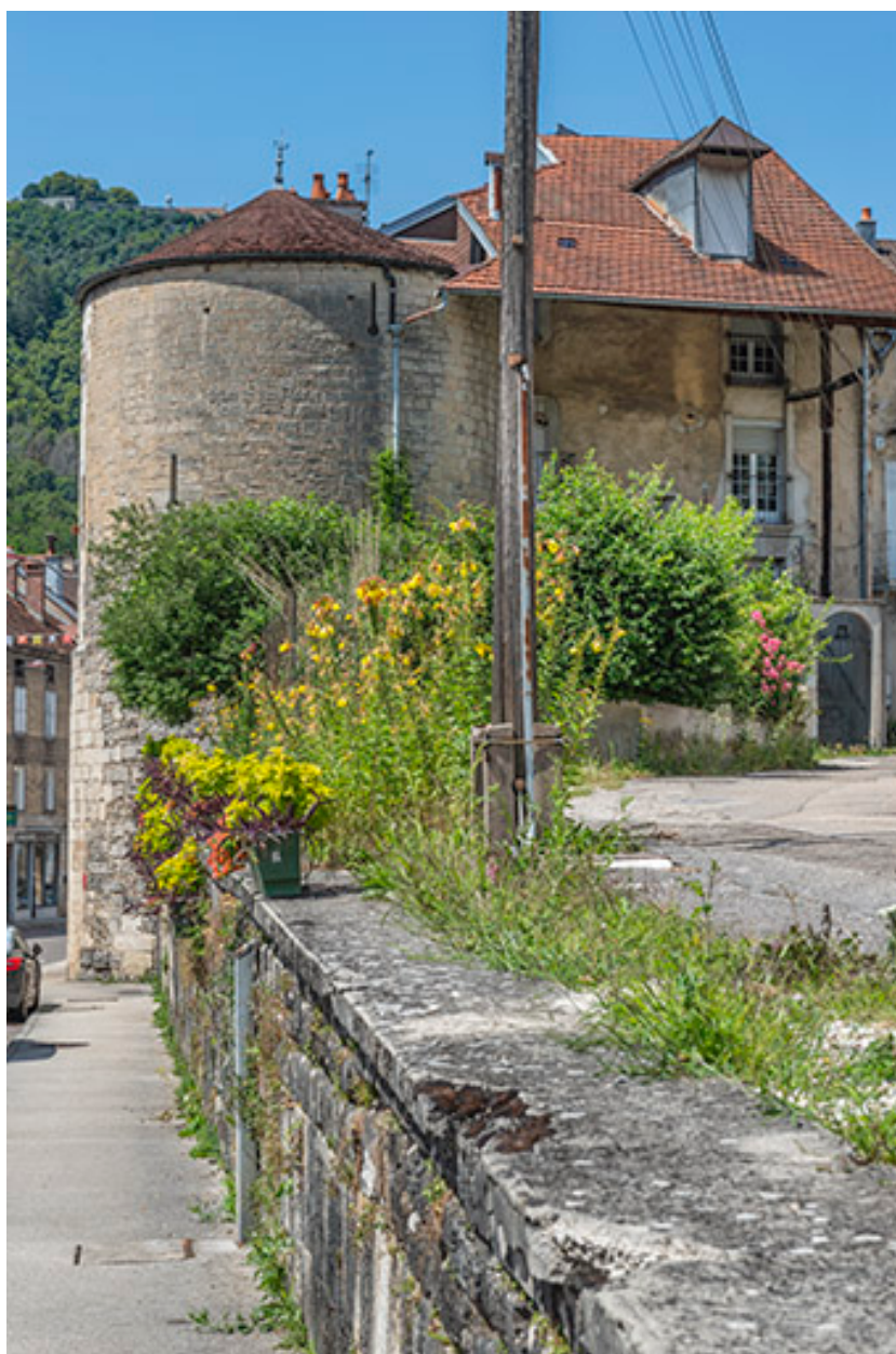
Tour Oudin et départ de la courtine sud.
