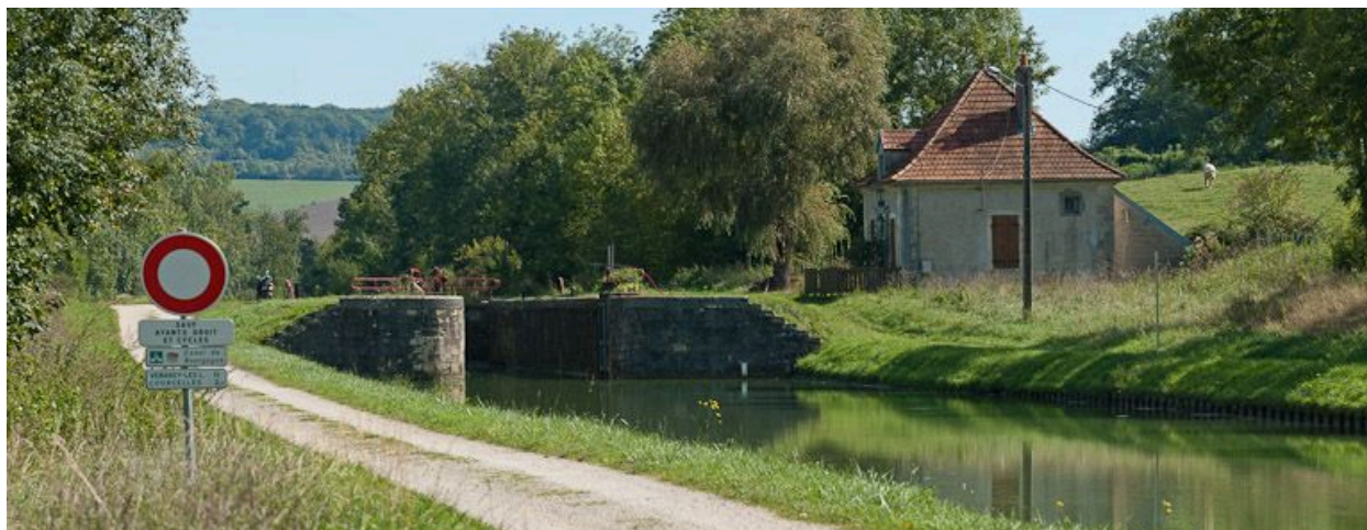
Vue du site d'écluse depuis l'amont.
