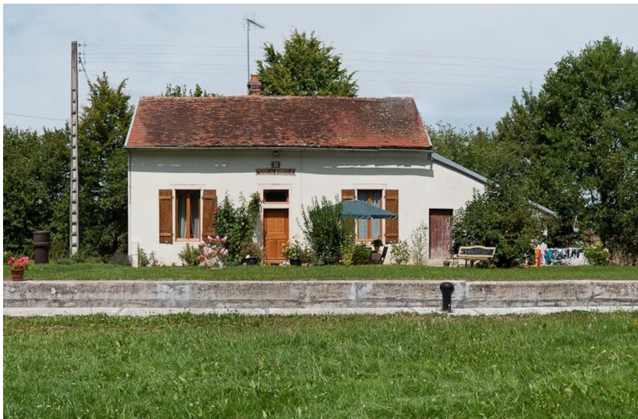
Vue de face de la maison éclusière.
