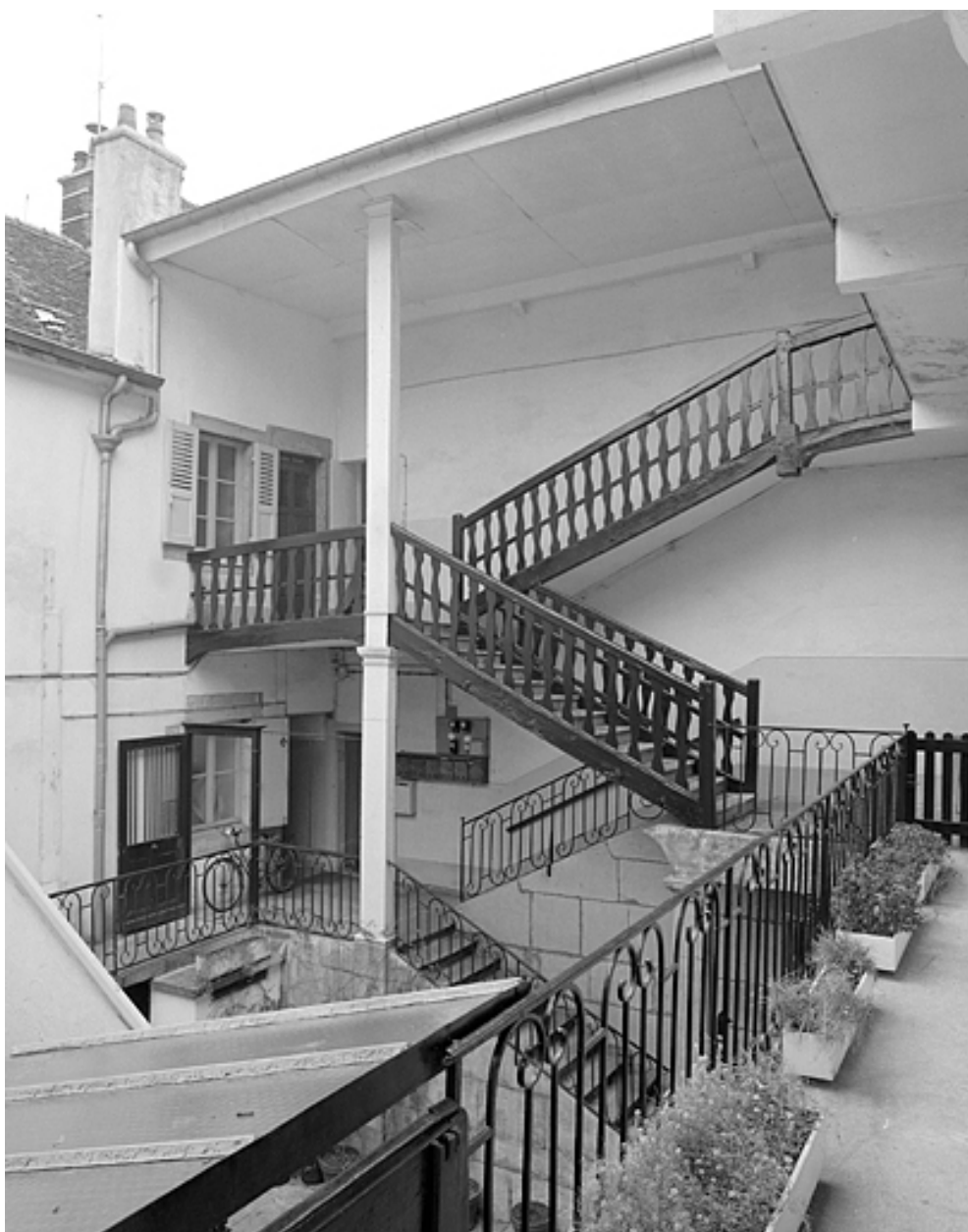
Escalier dans la cour.
