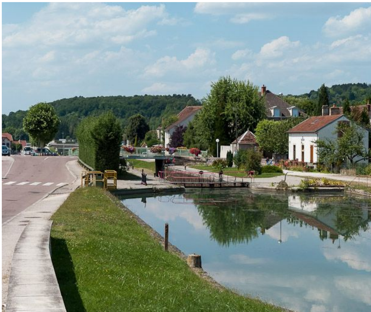
Vue d'ensemble du site d'écluse.
