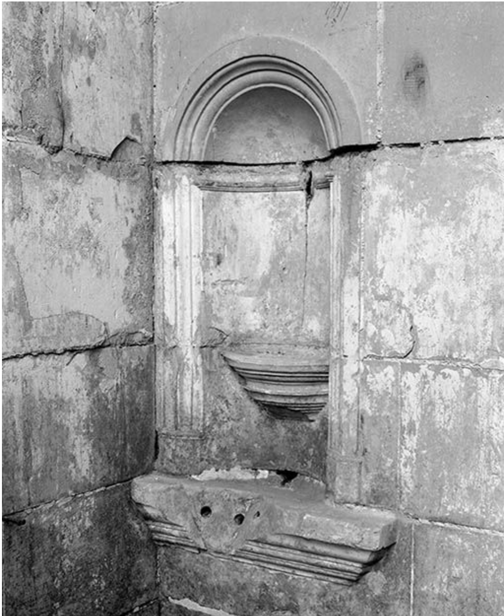
Chapelle sous clocher, lavabo.
