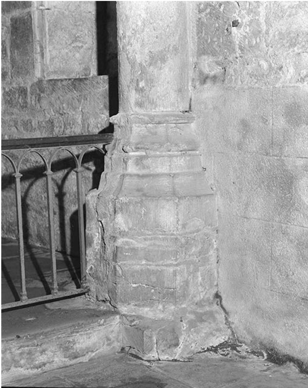
Bras droit du transept : base droite de l'arc-diaphragme donnant sur la chapelle.
