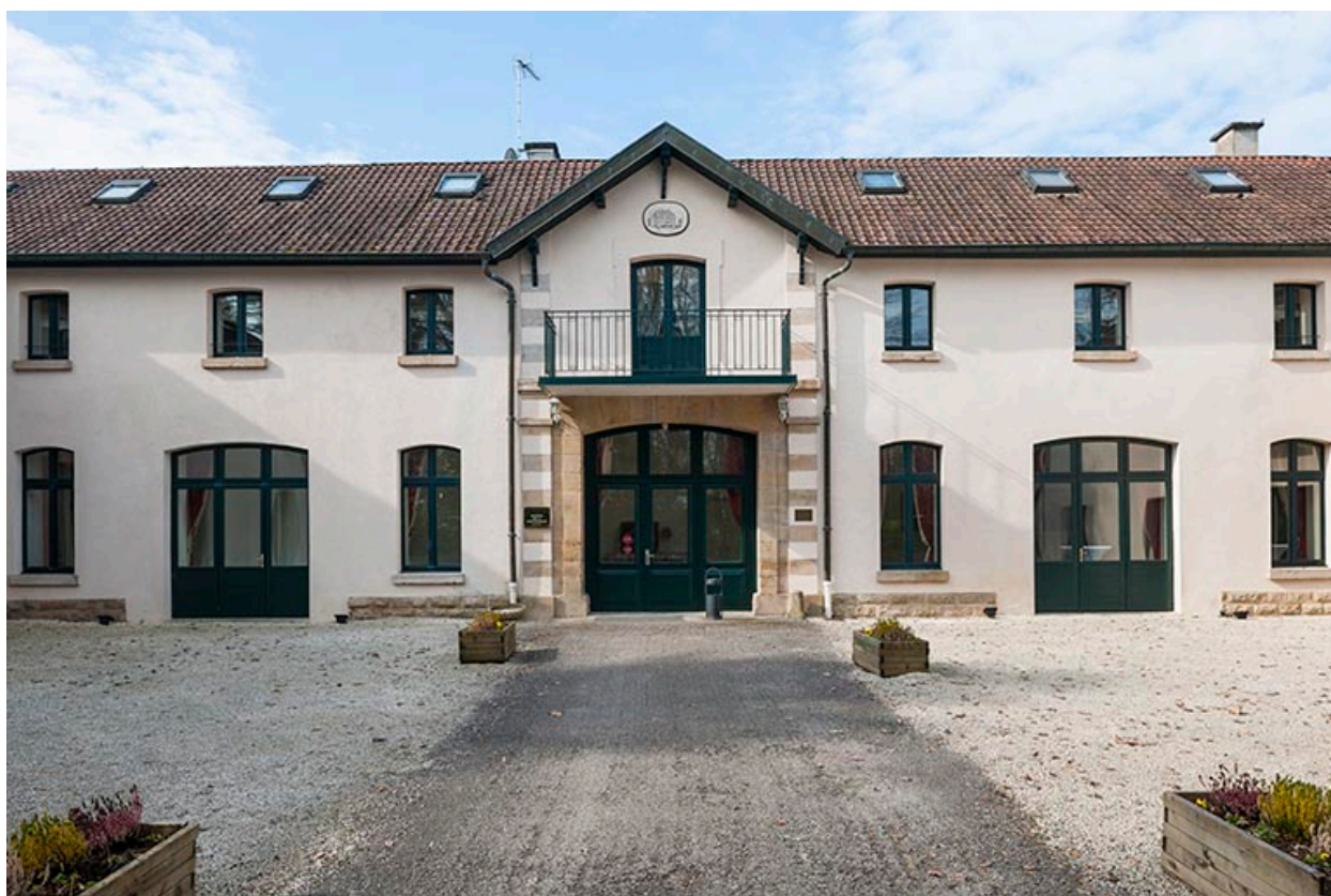
Bâtiment des communs. Travée centrale.
