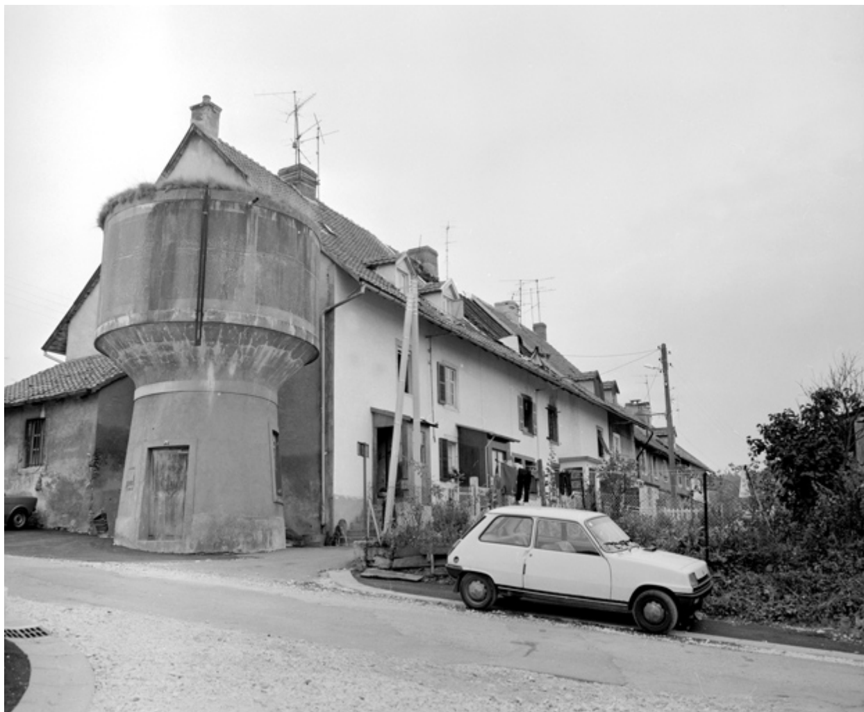
Caserne" rue des Bouleaux : vue depuis le nord en 1981.SRI. Enquête régionale sur les bâtiments industriels (1979-1981).
