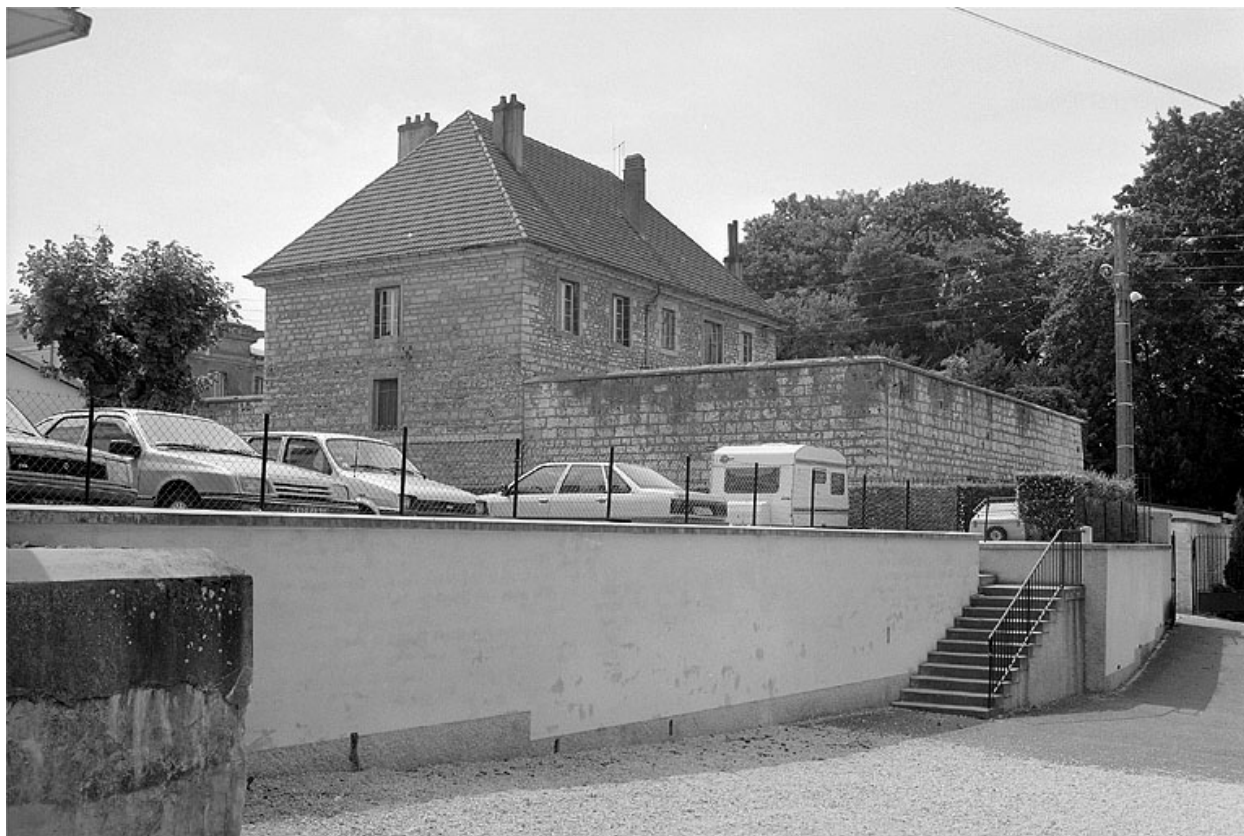
Façades postérieure et latérale droite.
