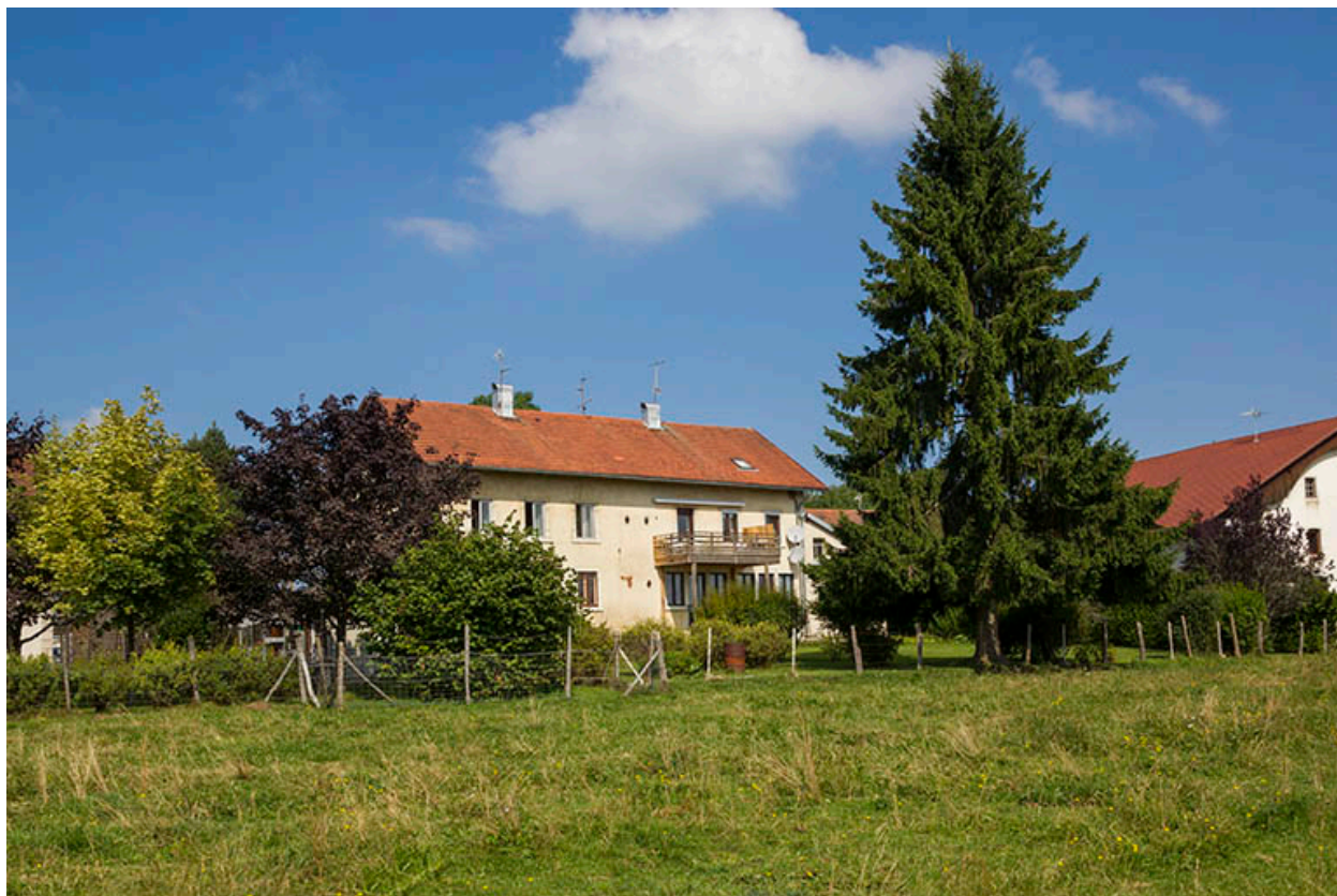
Vue d'ensemble, depuis l'est (façade postérieure).
