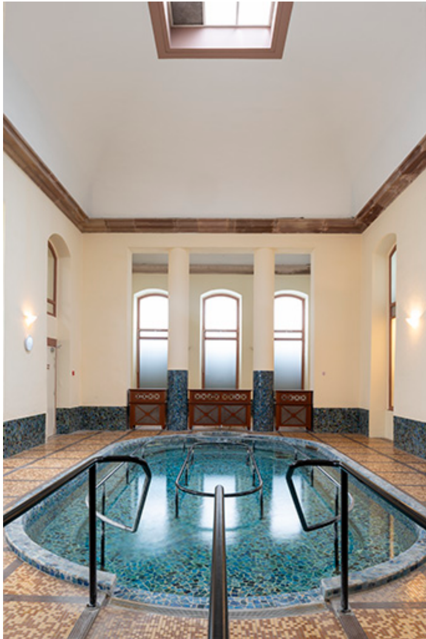
Piscine à l'emplacement du Grand Bain, bassin, vue en direction de l'ouest.
