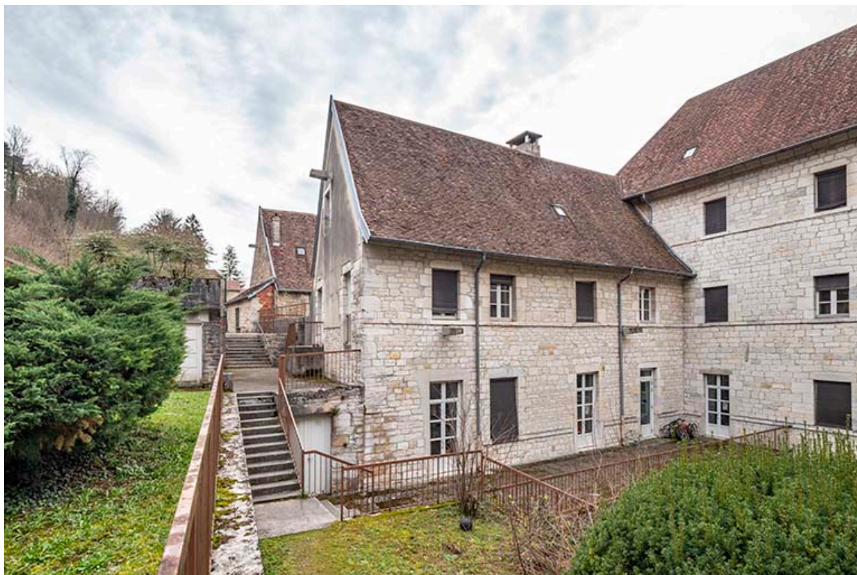
Façade sur cour de l'aile sud.
