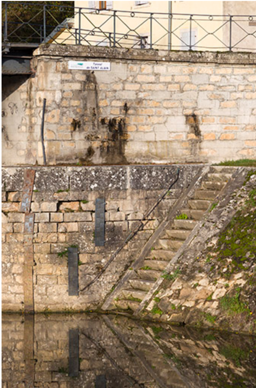
Détail de la maçonnerie.
