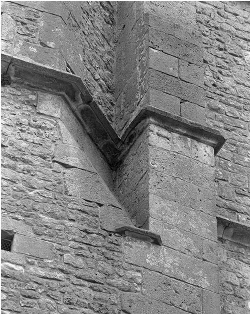
Tourelle d'escalier du clocher, détail.
