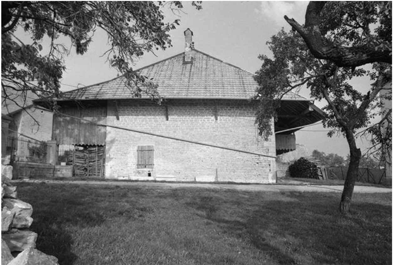
Façade latérale droite des parties agricoles.
