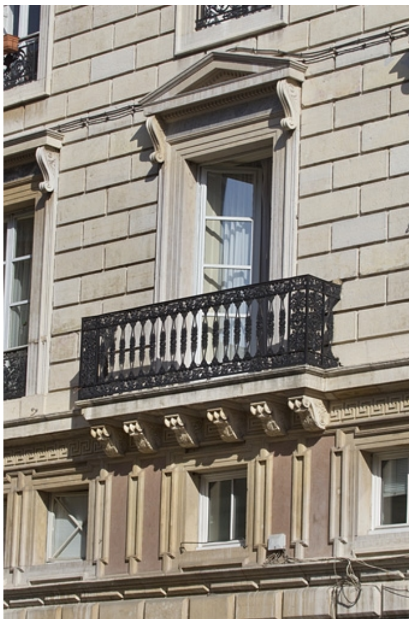
Façade latérale droite : détail du balcon.
