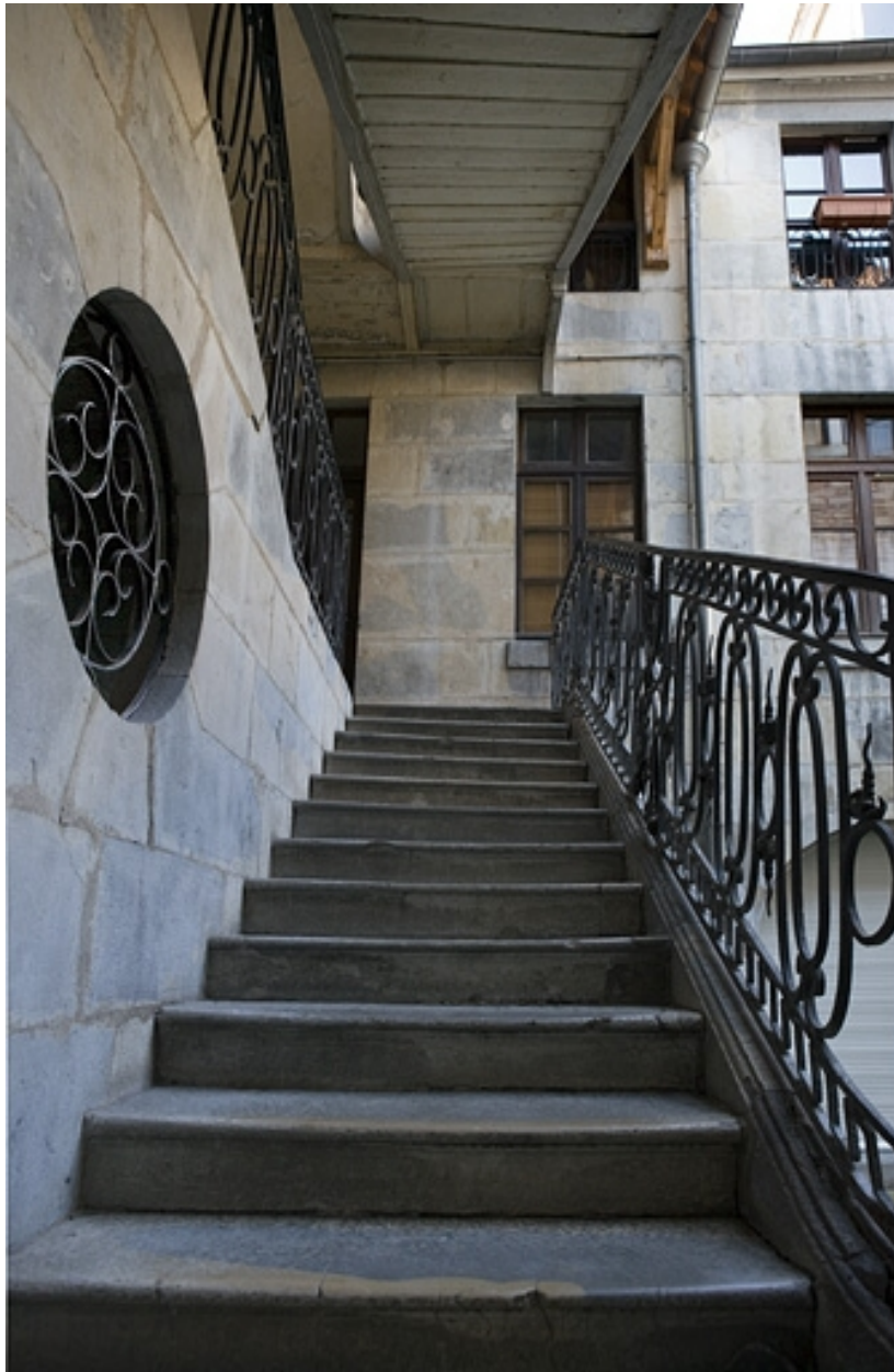
Détail de la première volée de l'escalier à cage ouverte.
