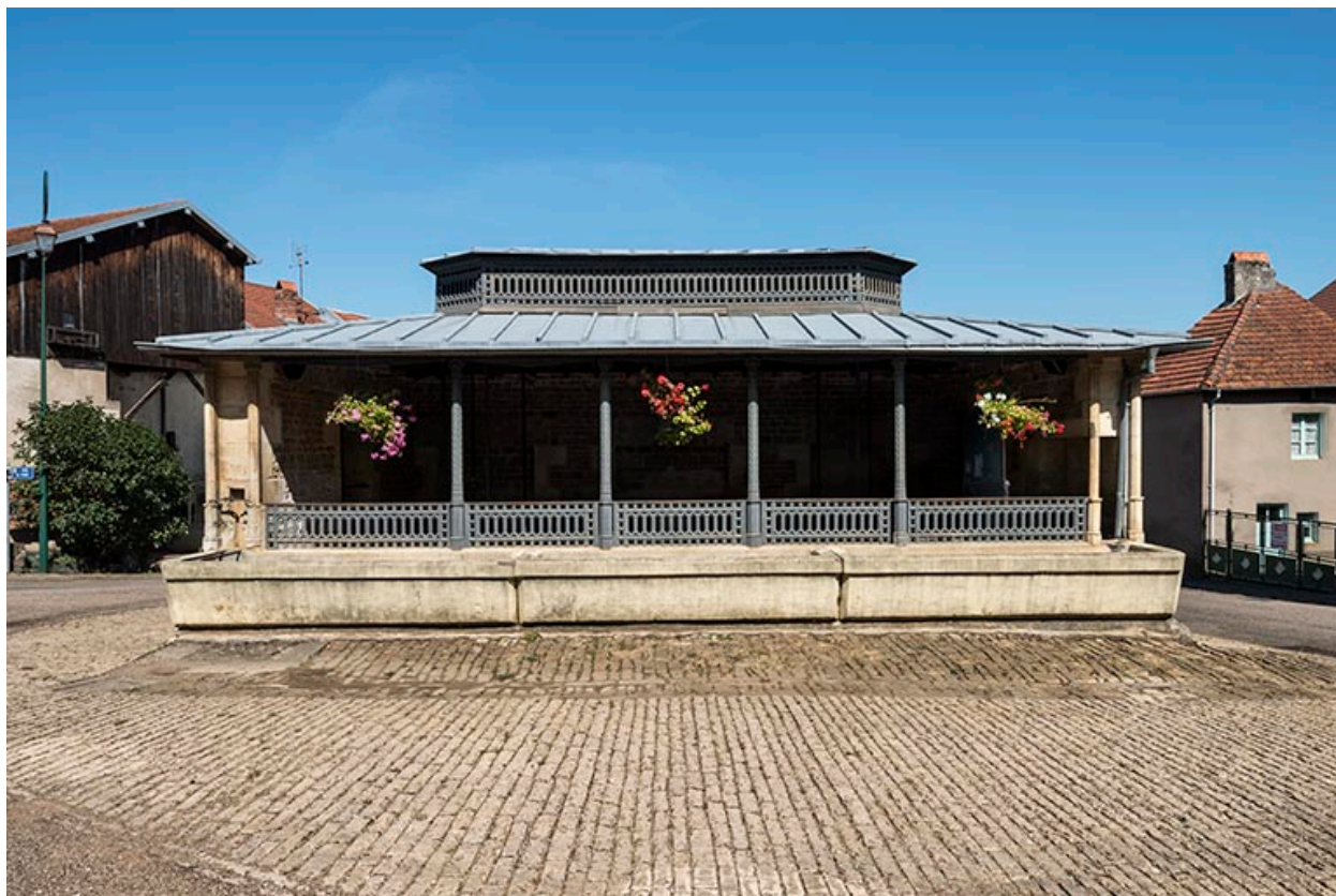
La façade antérieure de l'édifice.
